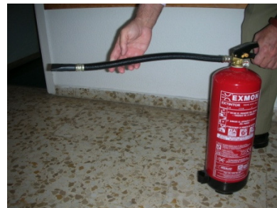
- Accionar el mecanismo de disparo presionando hacia abajo
