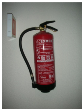
- Extintor de polvo polivalente, de 6 Kg Eficacia 21A -113B
